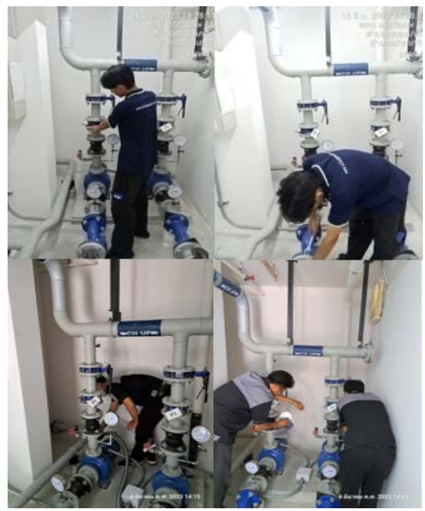
ภาคผนวกที่ 3.36 ตรวจสอบการรั่วซึมของท่อน้ำประปา
