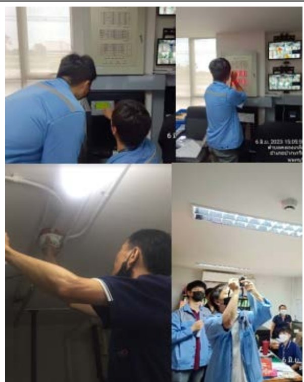
ภาคผนวกที่ 3.20 ตรวจสอบสภาพอุปกรณ์ ระบบสัญญาณเตือนอัคคีภัย
