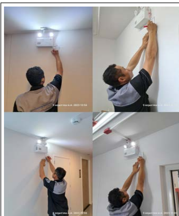
ภาคผนวกที่ 3.21 ตรวจสอบระยะจ่ายไฟฟ้าสำรอง
